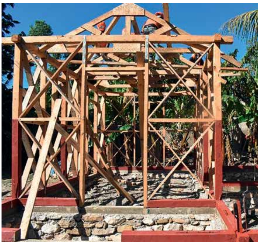
Blick auf eine Baustelle: Das Fundament und das Traggerüst aus Holz sind schon fertig. Nun folgt das Dach.
